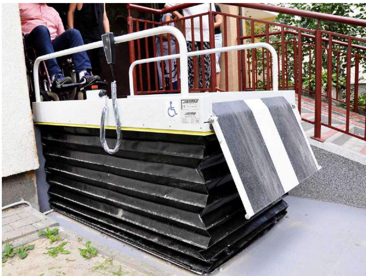
Podnośnik na górnym przystanku, rampa najazdowa w wersji manualnej.
