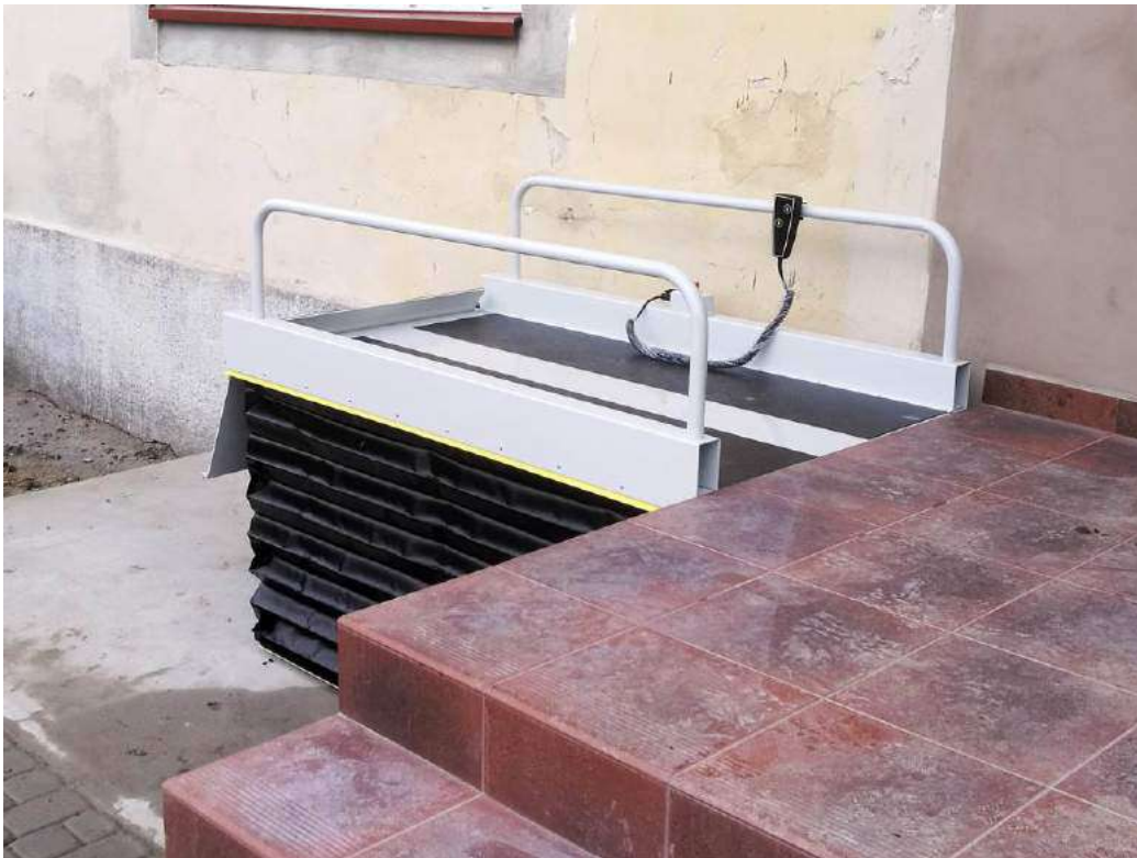
Górny przystanek - podnośnik podniesiony, rampa najazdowa w wersji manualnej.
