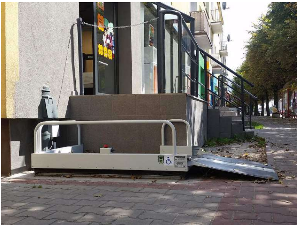
Dolny przystanek - podnośnik opuszczony, rozłożona rampa.
