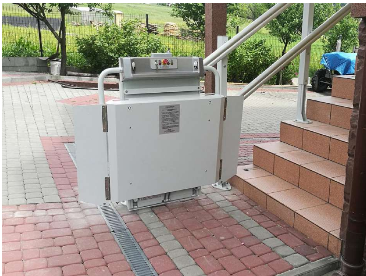
Przystanek dolny - platforma złożona, montaż szyny jezdnej na słupkach samonośnych.
