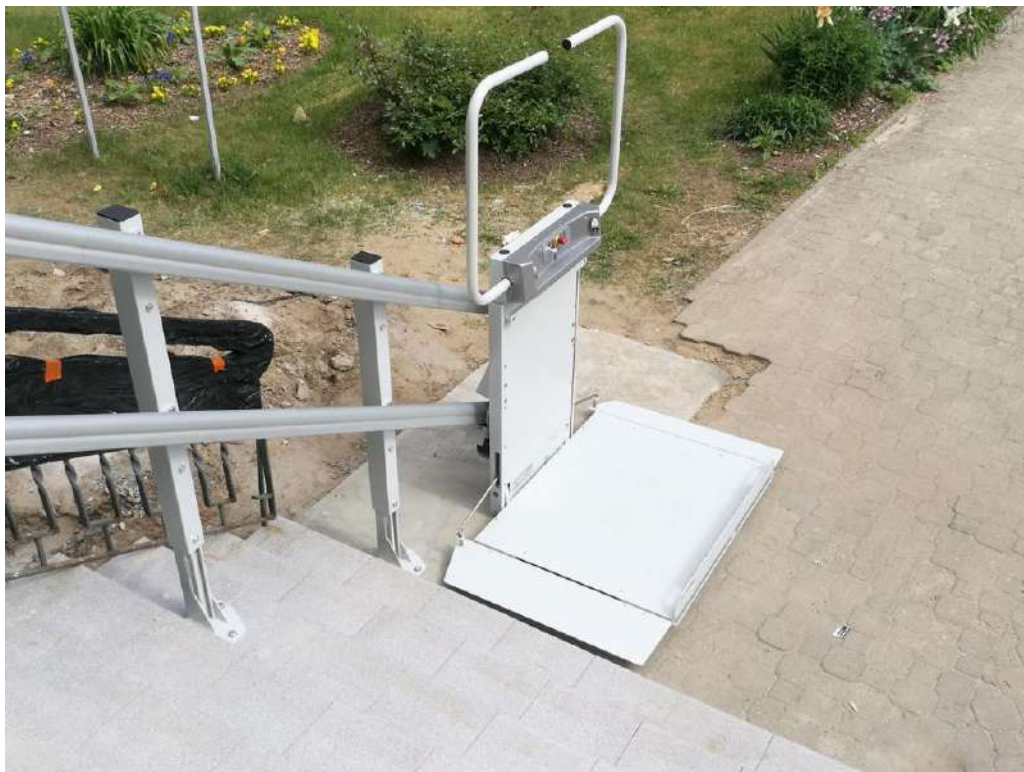
Przystanek dolny - platforma rozłożona, podniesione ramiona i opuszczone rampy. Montaż szyny jezdnej na słupkach samonośnych.
