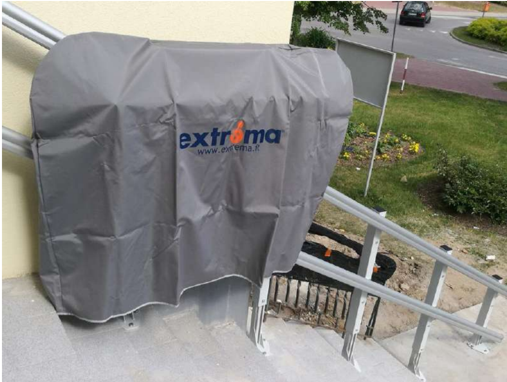
Przystanek górny - platforma złożona, pokrowiec ochronny. Montaż szyny jezdnej na słupkach samonośnych.
