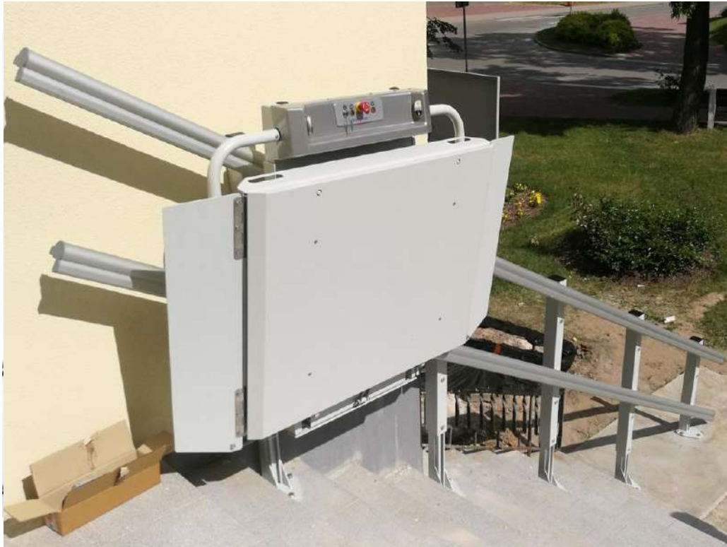
Przystanek górny - platforma złożona, montaż szyny jezdnej na słupkach samonośnych.
